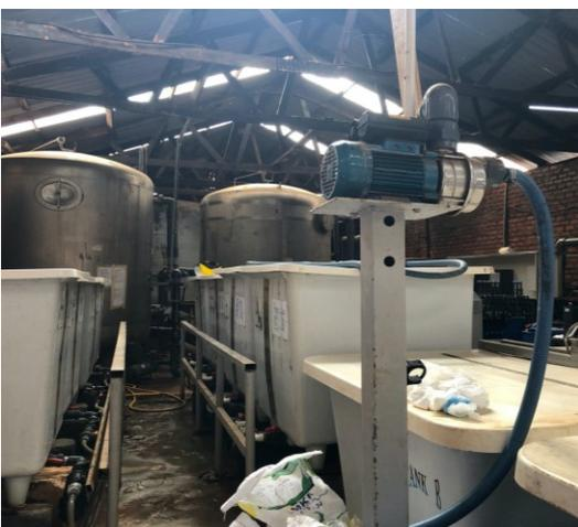
**Abb. 4: Wasserpumpe zur Filterung des Seewassers (KUNSCHKE 2020)**
