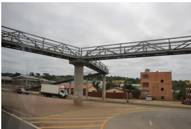
Abb. 16: Fußgängerbrücke zur Überquerung einer Hauptverkehrsstraße in Swasiland (KAGEL 2016)
