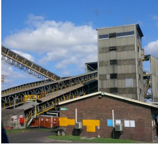
Abb. 10: Teile der Förderbandanlage (NIEDER 2016)
