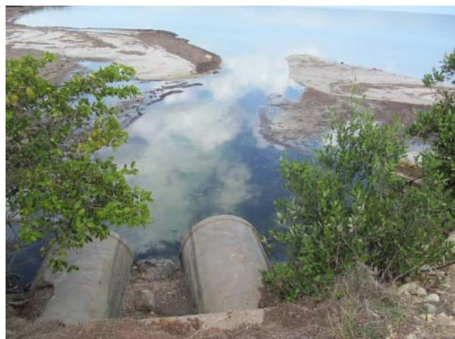
**Abb. 15. Sedimentation in Nähe von Durchlässen** (SUWALA 2013)
