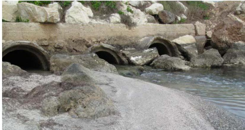
**Abb. 14: Rohre als Wasserdurchlässe** (SUWALA 2013)
