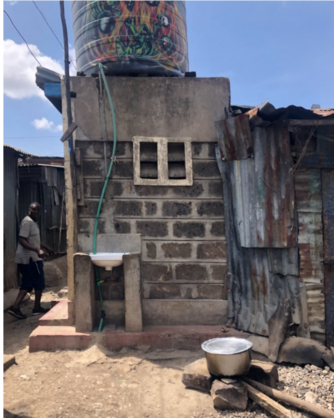
Abbildung 56: Öffentlicher Wassertank (EIGENE AUFNAHME 2021)
