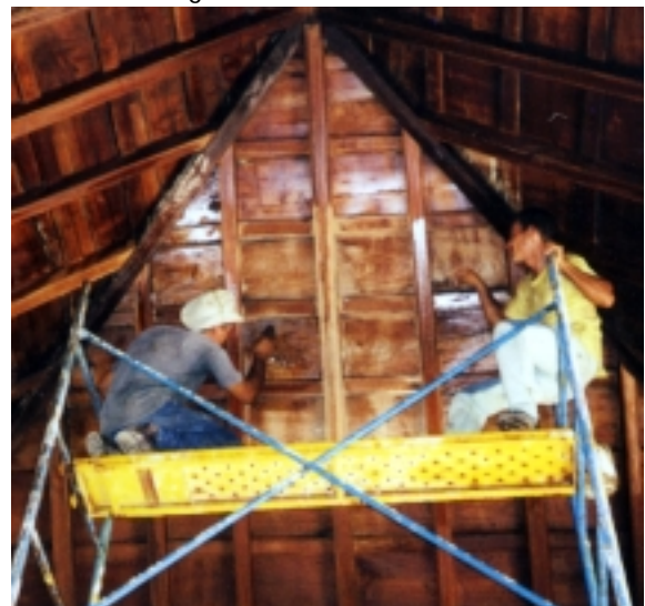
Restauration einer alten Holzdecke in einem Wohnhaus
